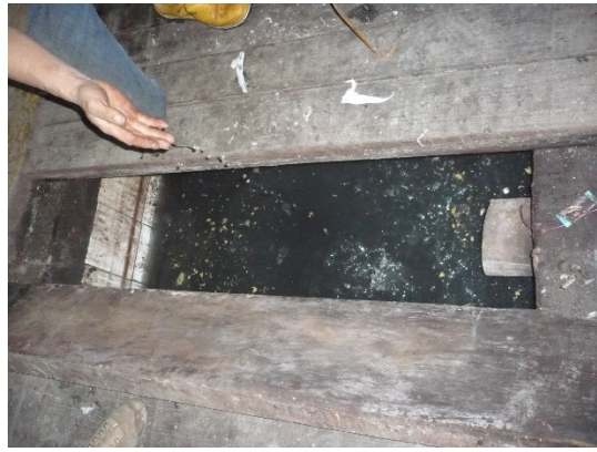
Foto No. 2 Agua Residual no Doméstica generada de procesos de recurtido y teñido
